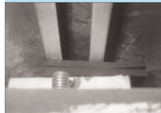
■ 그림 8-2. 신축줄눈 내부 방진패드 설치 사진
