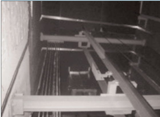
■ 그림 10-2. 엘리베이터 피트 내 벽체 흡음재 설치 사진
