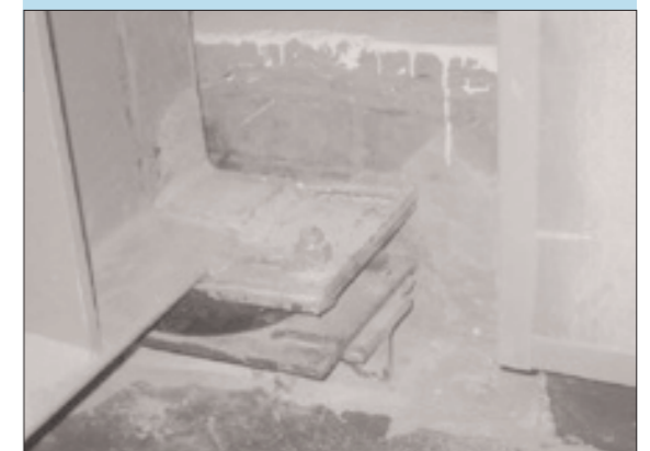
■ 그림 10-1. 엘리베이터 피트 내 소음기 설치 사진
